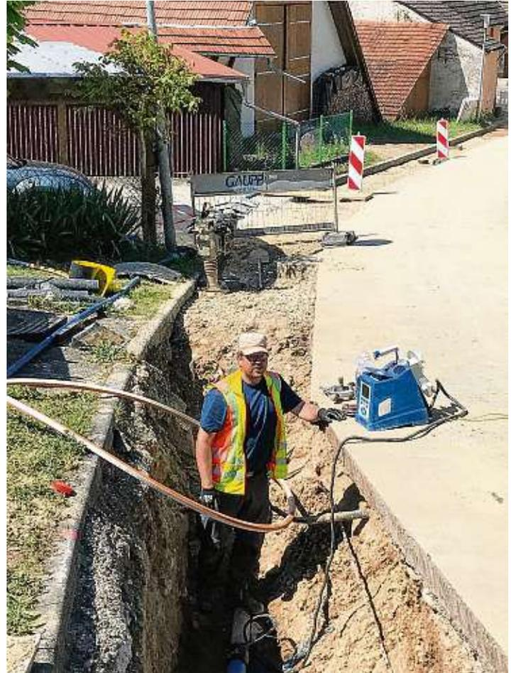
**Die Stadtwerke Engen** erneuern derzeit die Trinkwasserleitungen im Bürglenweg in Barga. Ein Austausch der Trinkwasserleitung ist in diesem Bereich altersbedingt notwendig geworden. Die Fertigstellung der Baumaßnahmen ist für Ende nächster Woche vorgesehen.
